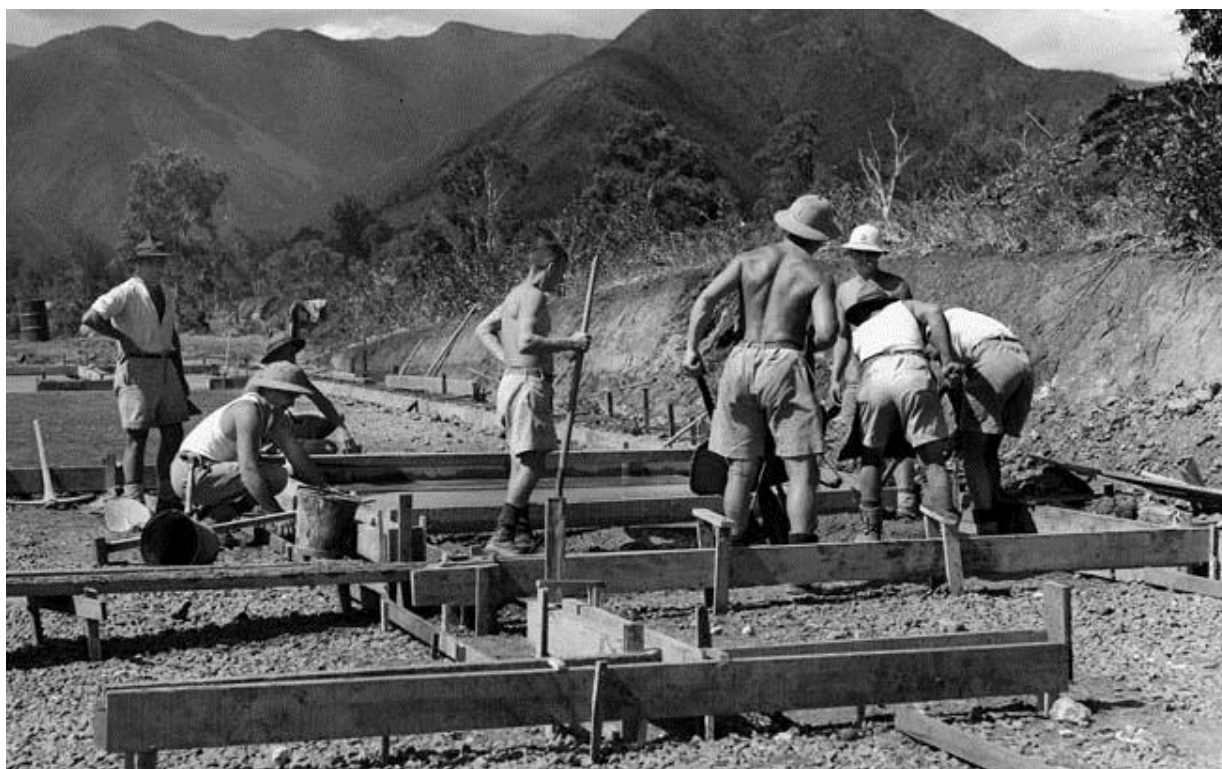
Новозеландские солдаты начинают строительство нового госпиталя на Новой Каледонии
