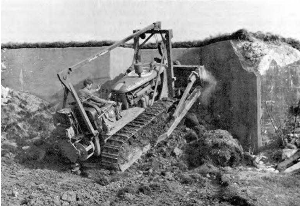
Бульдозер засыпает землей ДОТ в окрестностях Аахена ( http://tothosewhoserved.org/usa/ts/usatse03/chapter19.html )
