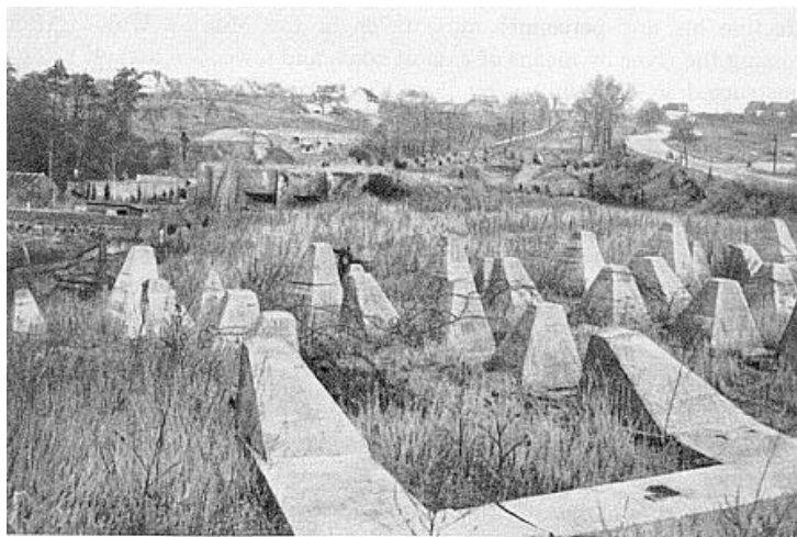
Ziegfried Line - Линия Зигфрида. На переднем плане бетонные надолбы (Dragon's Teeth - Зубы Дракона), на дальнем - доты
